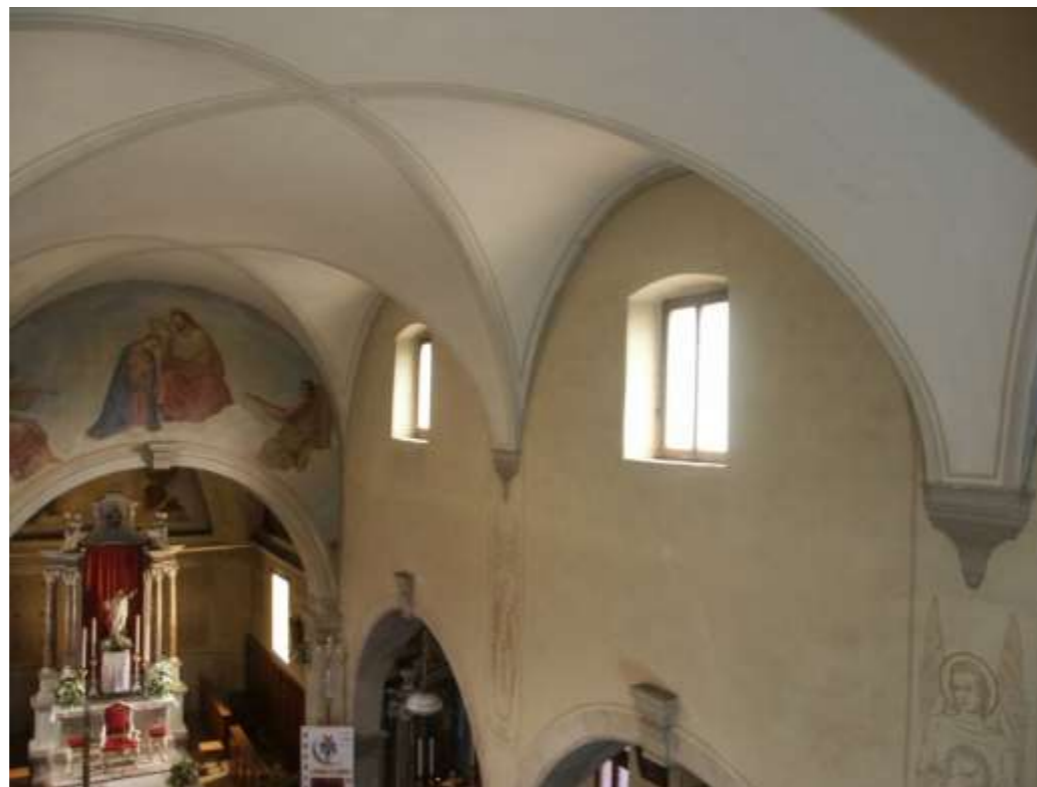
Foto 7: IINTERNO AULA VISTO DALLA CANTORIA PRIMA DELL'INTERVENTO
