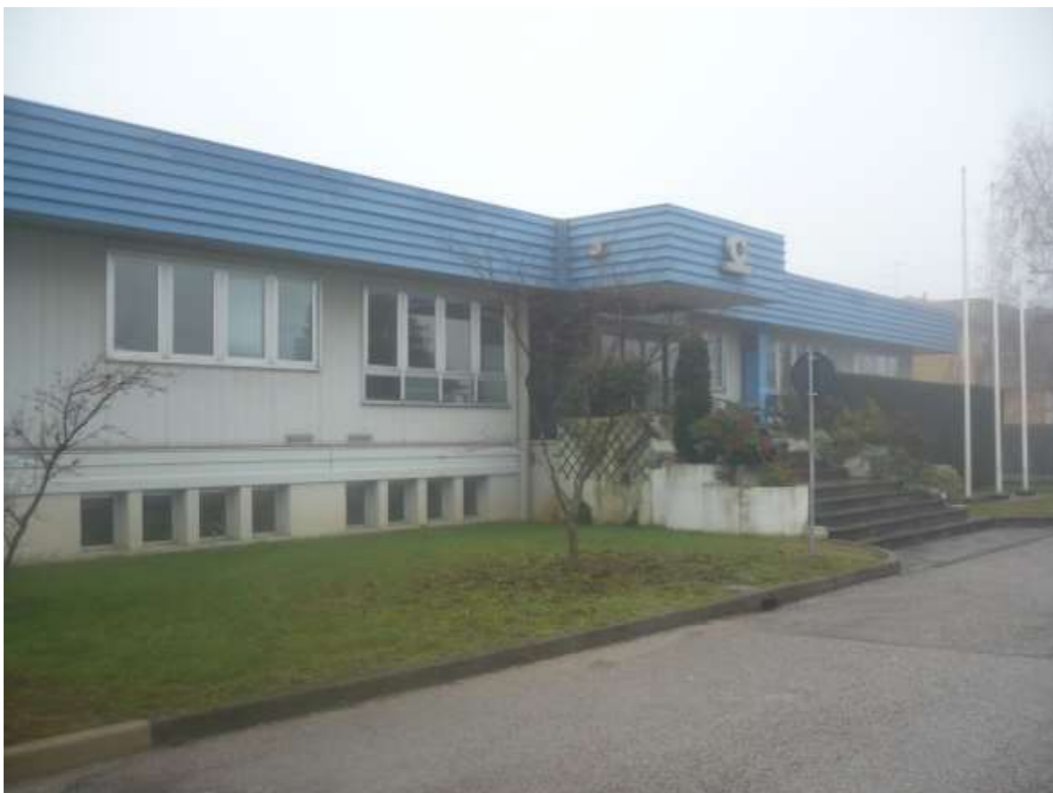
Foto 1 : Ingresso Principale lato via Cividina:
