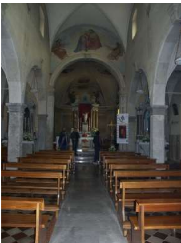
Foto 6: INTERNO AULA PRIMA DELL'INTERVENTO
