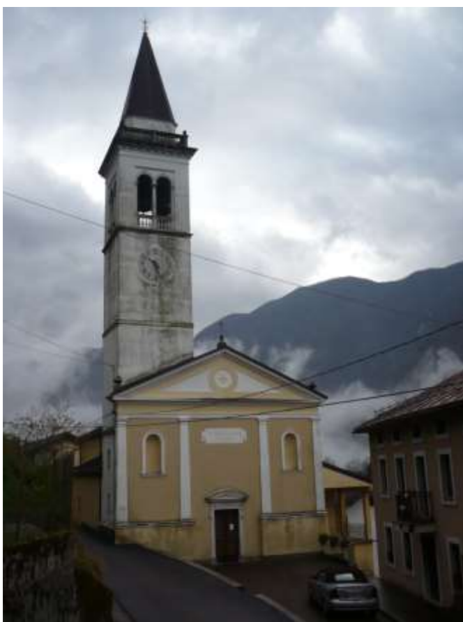
Foto 1: VISTA INGRESSO PRINCIPALE PRIMA DELL'INTERVENTO
