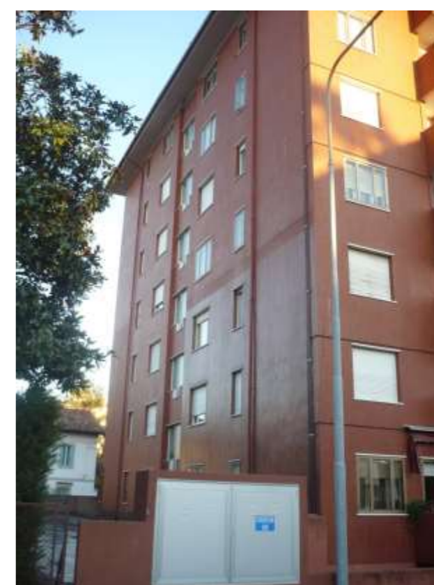
Foto 3: Lato Est Prima dell'intervento
