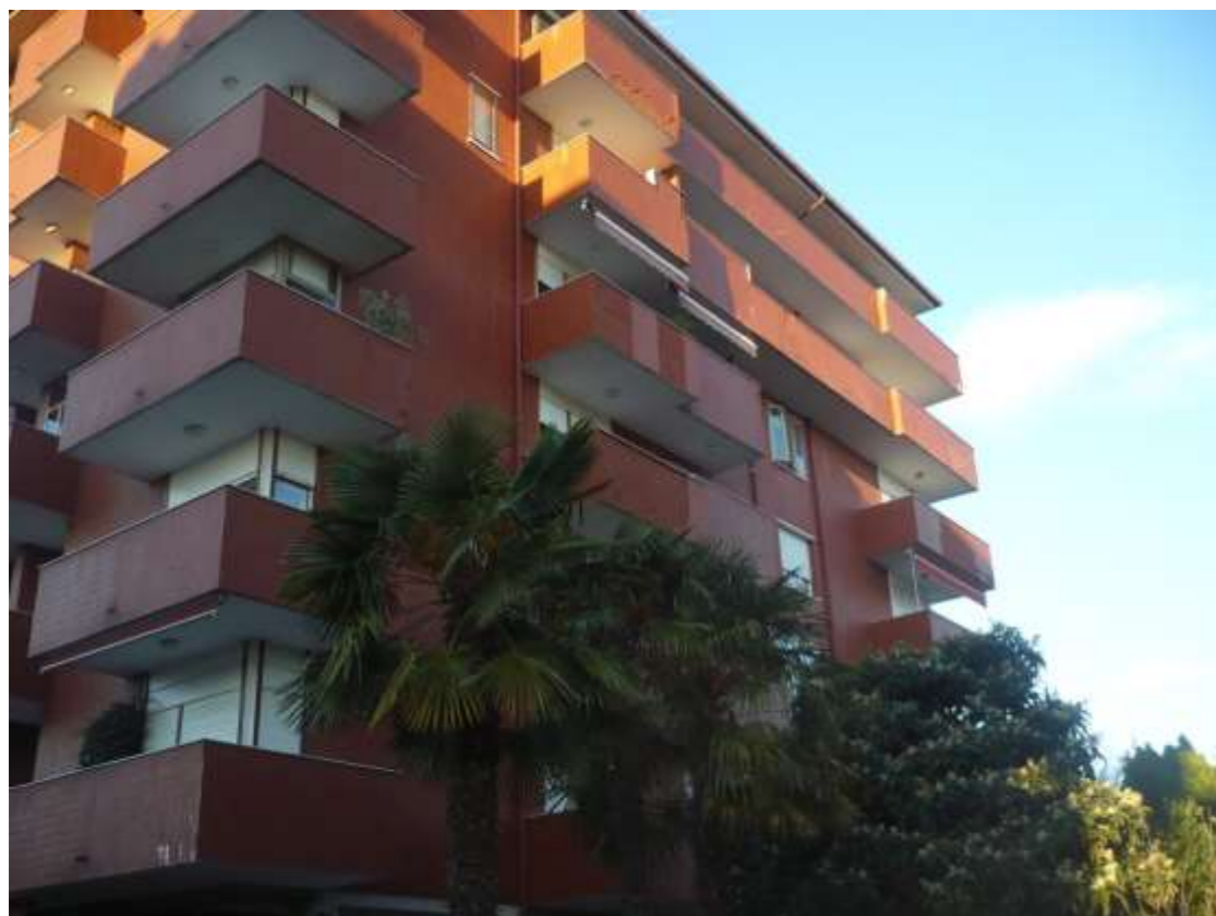
Foto 1: Lato Ovest Prima dell'intervento
