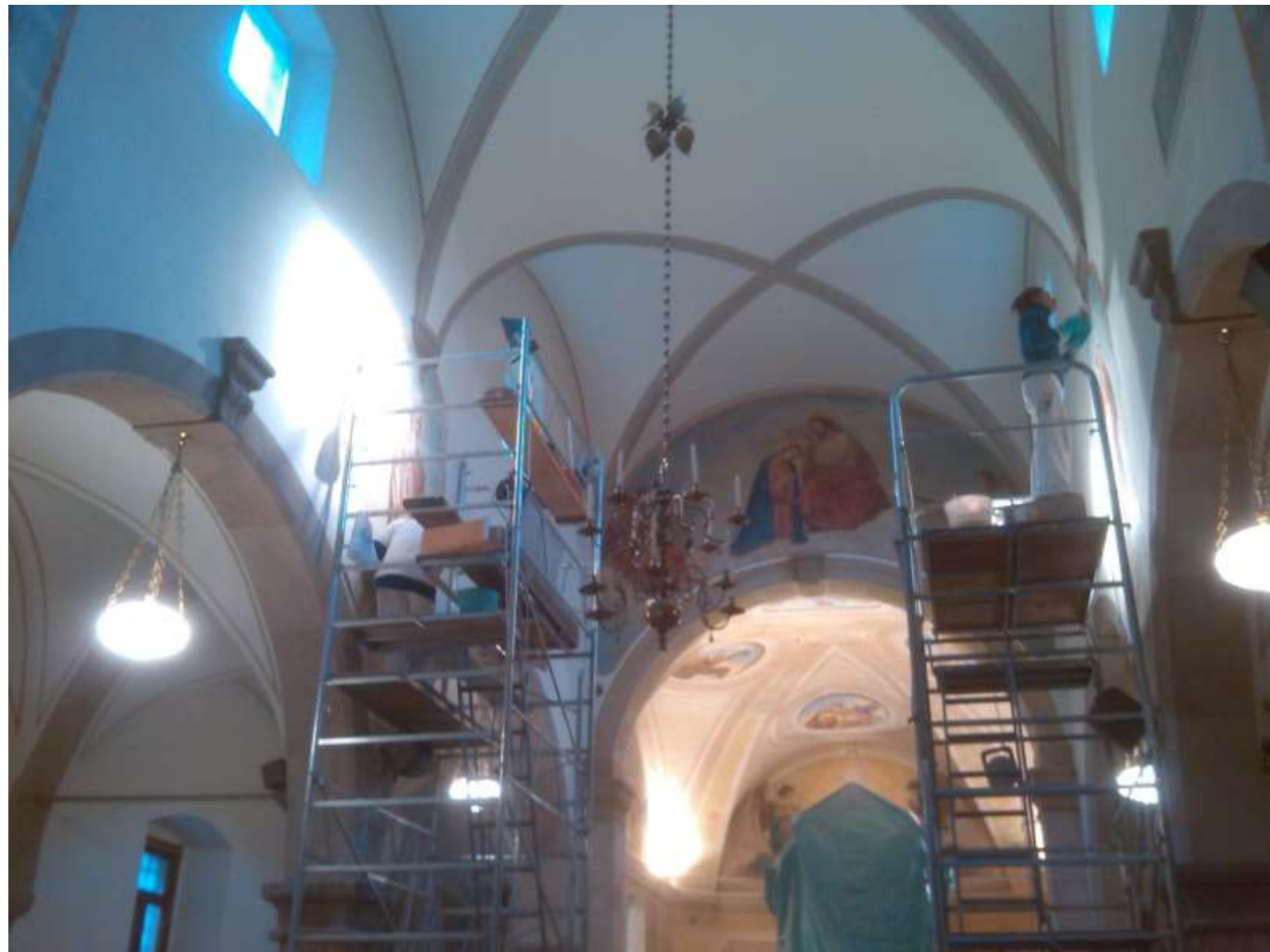
Foto 13: Gli interni a restauro quasi terminato.-
