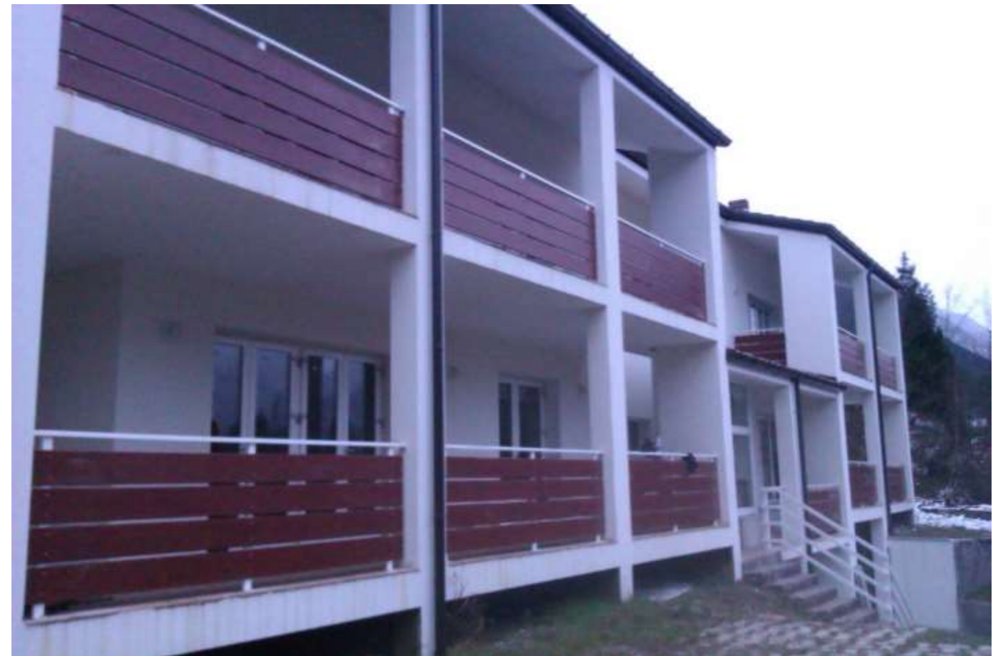
FOTO 2: FRONTE PRINCIPALE CENTRO AGGREGAZIONE DOPO LA RIQUALIFICAZIONE LE BALCONATE IN "WERZALIT"
