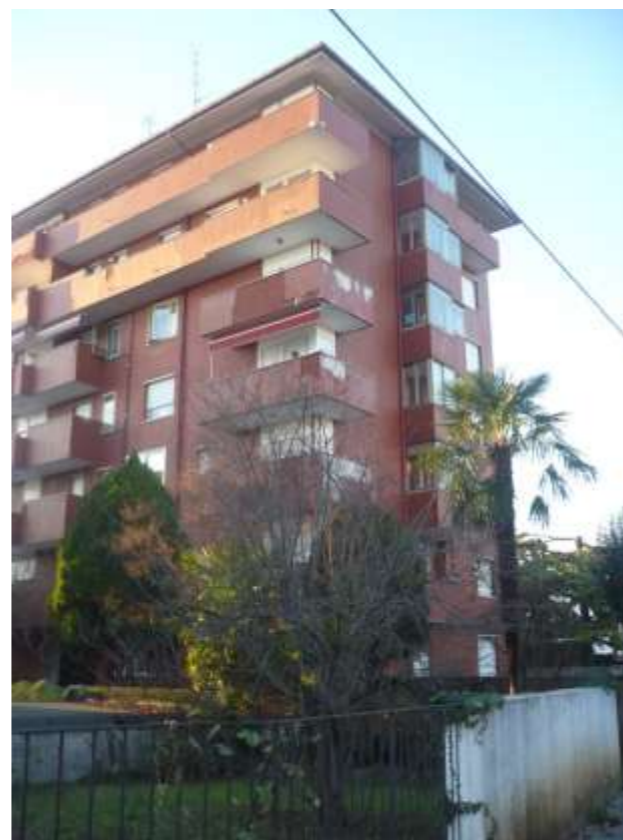
Foto 2: Lato Nord Prima dell'intervento
