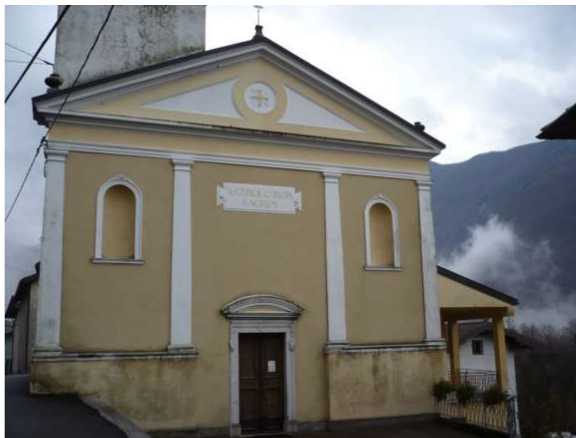
Foto 2 : INGRESSO LATO OVEST CHIESA
